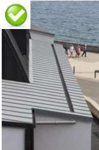
Çatı ve oluklarda eğim prensibine %100 uyulmuştur.
