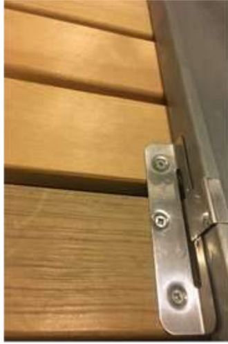
Hareketli klipsler ahşap alt yapıdan bağımsız çalışır.
