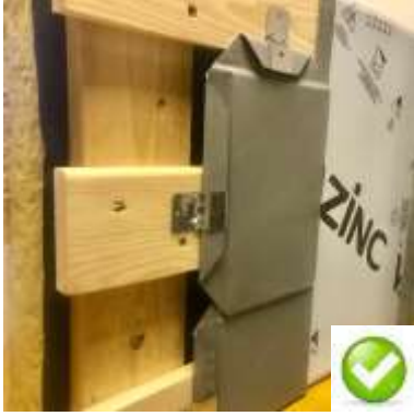
Standartlara uygun 2 cm havalandırma kesiti
