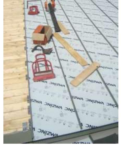
Hareketli klipsler saçak ucunda daha sık kullanılmalıdır.
