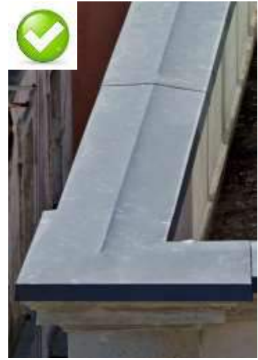
Geniş harpuştada çift yöne eğim verilerek eğim prensibine %100 uyulmuştur.
