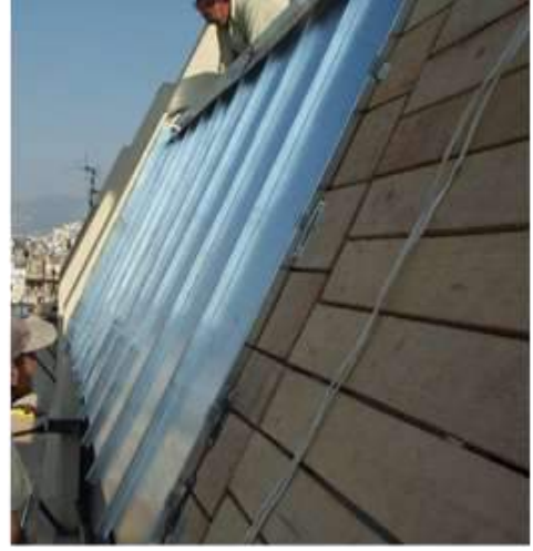
Vida başları potluğa sebep olmayacak şekilde, ahşapla hemyüz olmalıdır.
