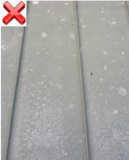
Yetersiz eğim önce beyaz pasa sonra delinmeye yol açacaktır.
