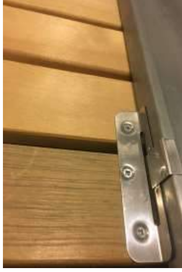
Hareketli klipsler ahşap alt yapıdan bağımsız çalışır.
