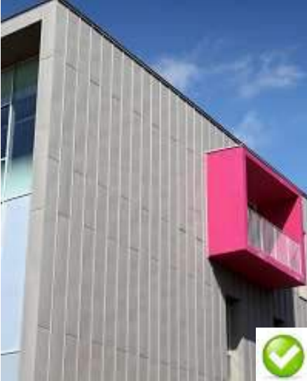
Standartlara uygun yatay eklem çözümü, tolere edilebilir dalgalanma
